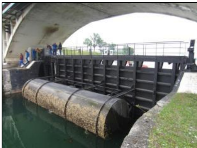
Vue aval de la porte de garde en place sous le pont (côté bassin)
